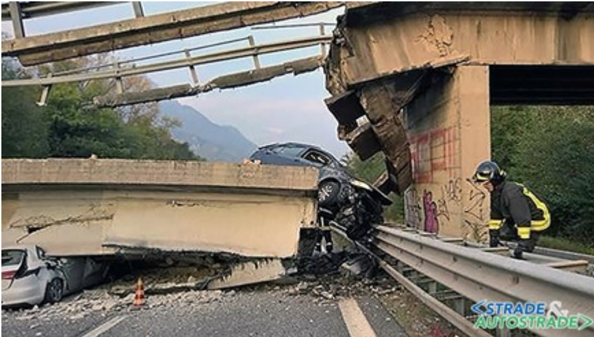
Figura 21 Collasso ponte Annone per cedimento sella Gerber (D. Masera-R. Asso-G.C. Marano, Strade & Autostrade, 2021)
