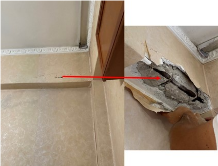
Figura 8 Esempio di corrosione uniforme su una trave in c.a. promossa dalla carbonatazione in un fabbricato di civile abitazione realizzato negli anni cinquanta
